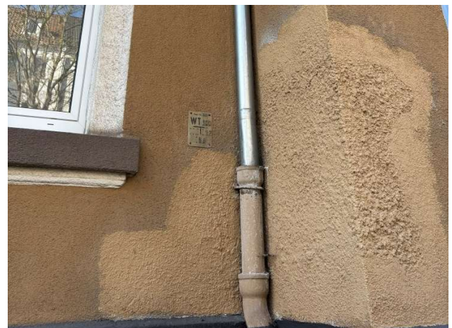
Foto Nr. 6 Fassade: Feuchtigkeitsschäden
