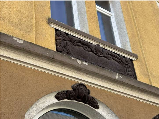
Foto Nr. 7 Fassade: Rissbildung in Relief-Elementen
