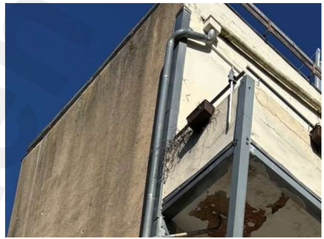
Foto Nr. 4 Innenhoffassade, Putzschäden, mangelhafte Tropfkante
