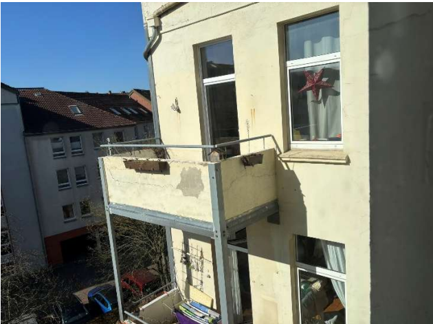
Foto Nr. 1 Balkon Konstruktion; Feuchteschäden & Risse (Bsp.)
