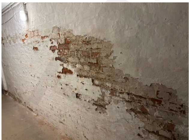
Foto Nr. 5 Feuchtigkeitsschäden Keller (beispielhaft)
