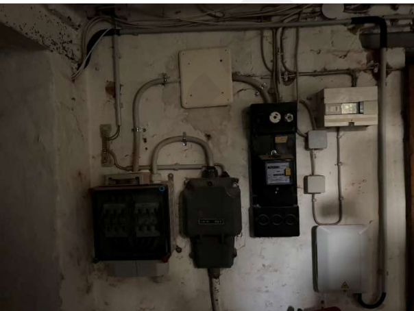
Foto Nr. 11 Zentrale Elektroinstallation / NSHV im Keller
