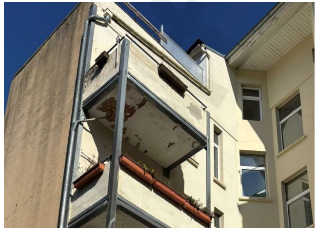
Foto Nr. 2 Balkon Konstruktion; Feuchteschäden & Risse (Bsp.)
